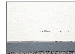
Fest kabelen med klips
